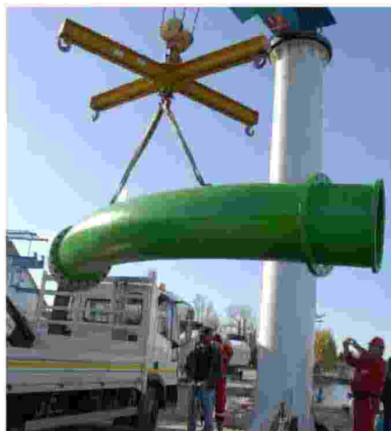
Interventi sul collettore del Garda. Si avvicina il rifacimento
