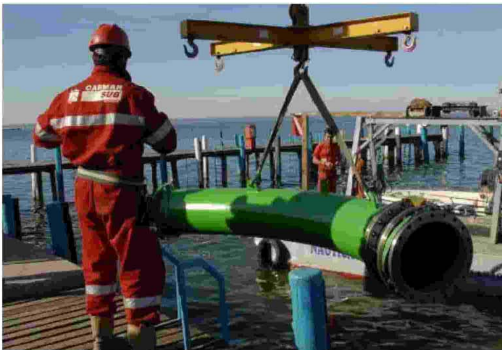
Lavori di posa di tubazioni della rete del collettore del Garda
