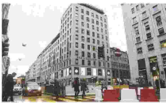
BORGOGNA Il cantiere del silos e sopra Stefano Parisi
